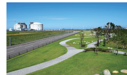
ひびきどんぐり公園（全景）
